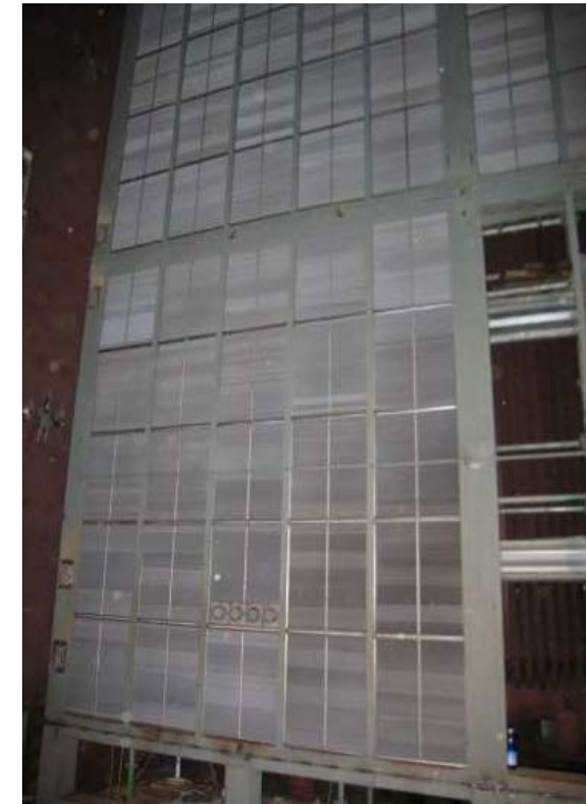
Fig.3: Montaggio Moduli Catalizzatore
