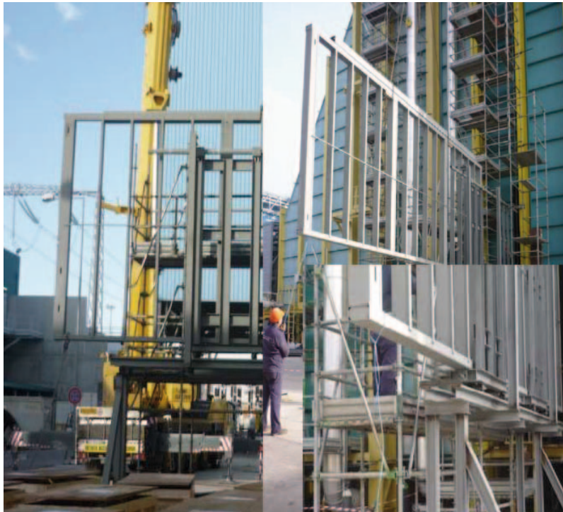
Fig.1: Inserimento frame di supporto
